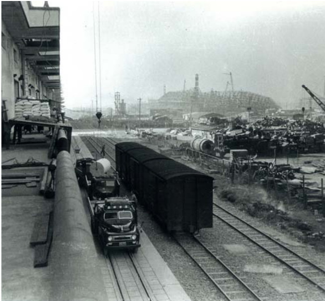
晴海線の荷役作業
